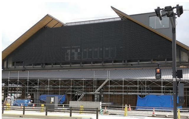
着々と工事が進む新たな陸前高田市立博物館
