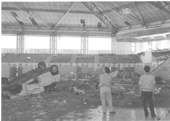
博物館と隣接して建っていた市立体育館内の惨状
