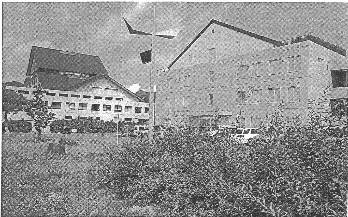
文化財保存修復研究センター(右)と本館(左)。
