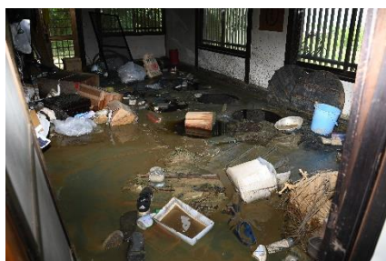
紺屋場 被災直後（藍生庵提供）
